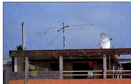
Die 2 x 8-Element-Gruppe von Hermann und Peter als D44TVG: Man kann auch mit deutlich weniger Aufwand als beispielsweise bei 3DA0MB erfolgreich via Mond funken.
