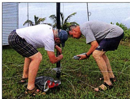
Dank eines effektiven Radialnetzes erzielten wir auf 80 m ein gutes SWV.
